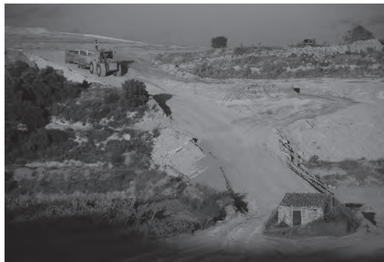
Figura 1. Vista de les obres de construcció del Canal Segarra-Garrigues a Verdú
