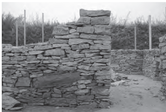
Figura 21 Vista del remuntatge en curs de la cabana de Corral Nou (Verdú, l'Urgell)
