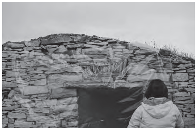
Figura 20 Detall del calc realitzat per a permetre el remuntatge de la cabana de Corral Nou (Verdú, l'Urgell)
