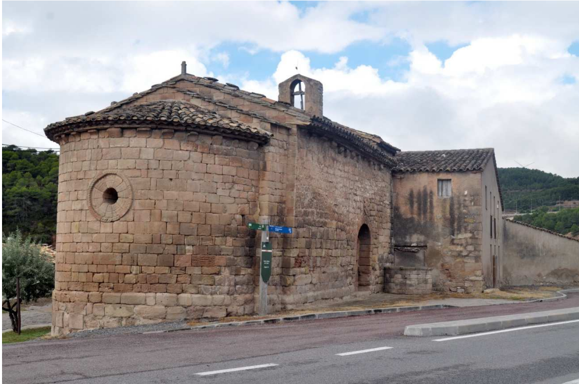
Vista de la façana nord
