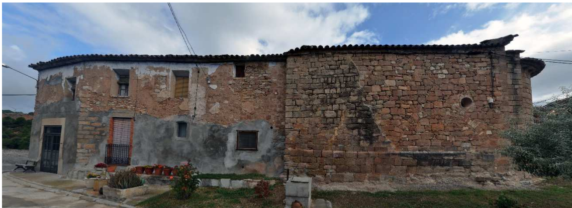
Vista de la façana sud. A l'esquerra, l'habitatge adossat
