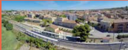
Vista aèria de l'espai de l'estació de ferrocarril amb la vila de Juneda al fons.
