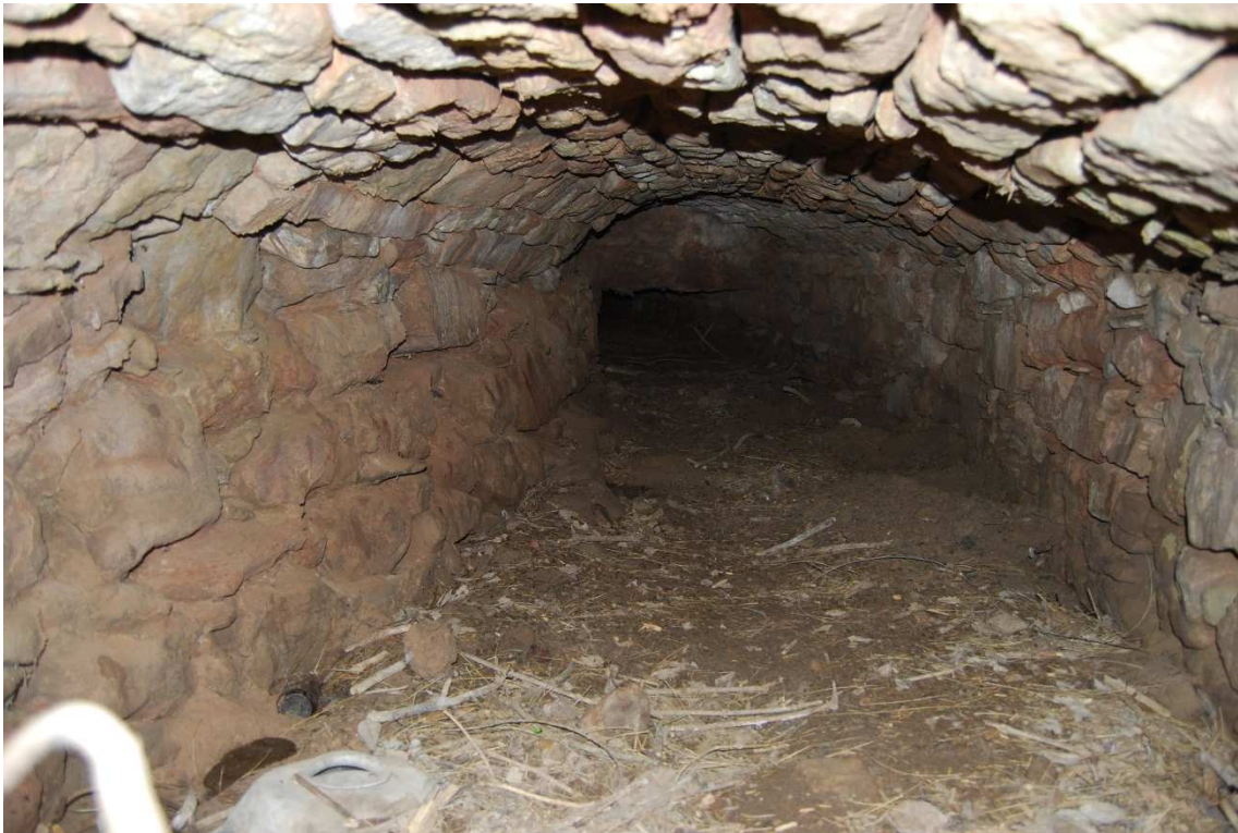
Interior de l'estructura de desguàs.
