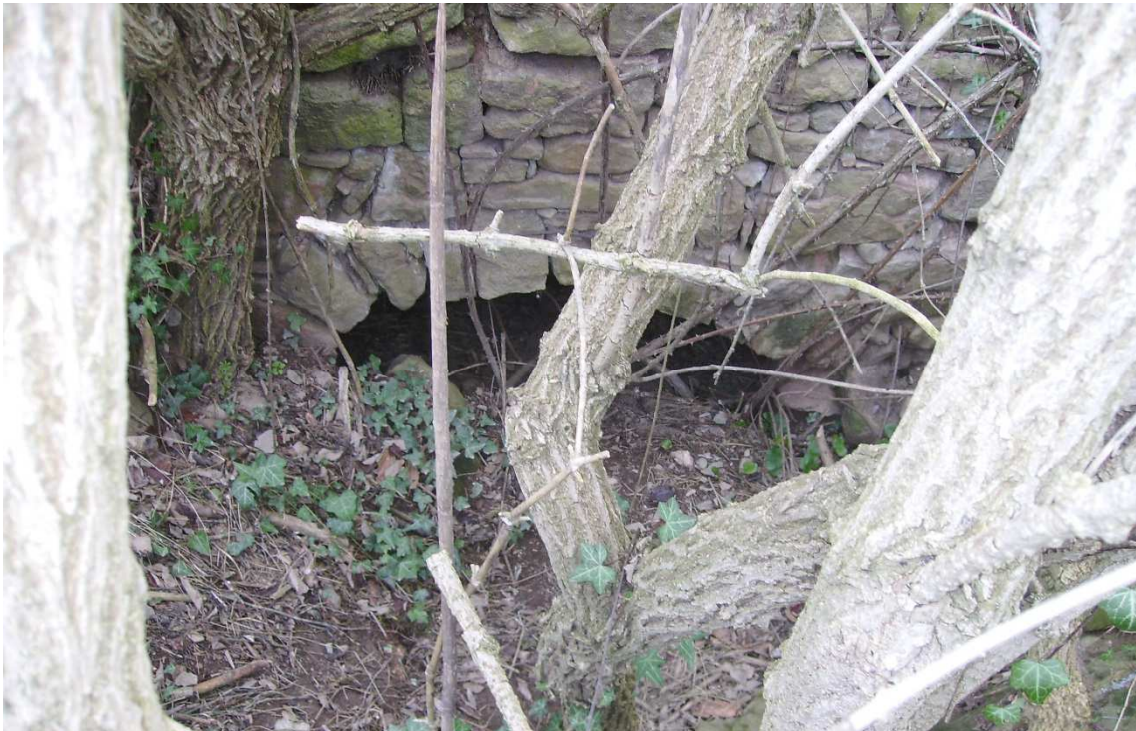
Obertura de desguàs de l'edifici principal. Actualment es troba soterrada per la terra acumulada, que es va dipositar en aquest sector, provinent de l'actual hort.
