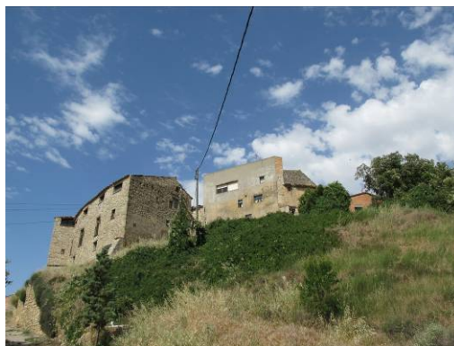
Vista parcial del Soler
