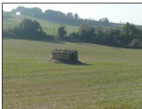
Barraca de Pedra Seca a Carbasí
