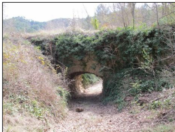
Pont de la Rasa de Coma-Sarda
