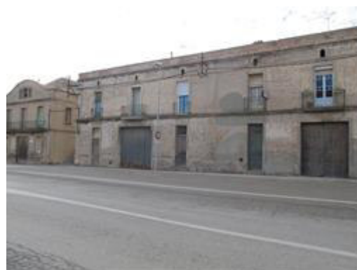
Edificis vora la carretera Llarga
